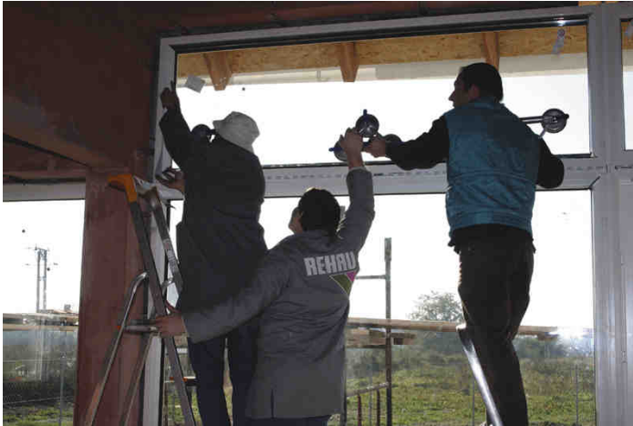
Abb. 6. Montage der Fenster.
