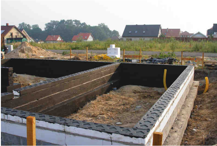
Abb. 3 Verteilung der Mauerfußhohlsteine Isomur
