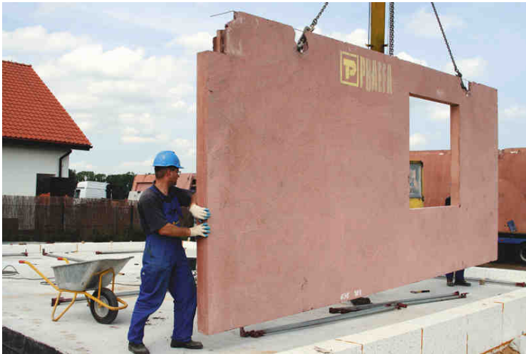
Abb. 4 Montage der Fertigbauteile aus Blähtonbeton.
