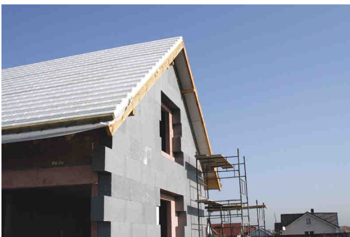
Abb. 5 Wärmedämmung der Außentrennwände.
