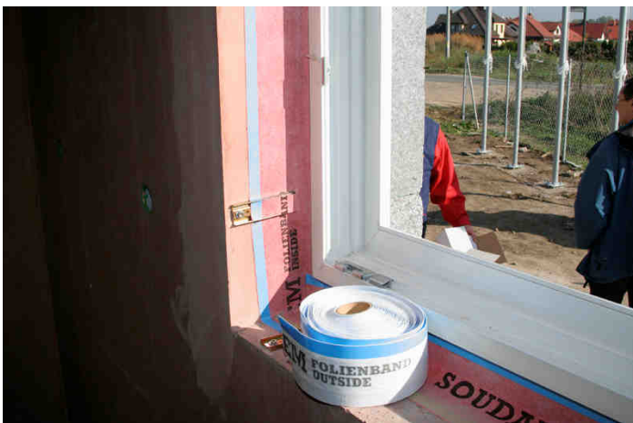
Abb. 7 Dichte Verbindung der Außenwände mit Fenstern – dampfdichte Folie vor dem Aufkleben
