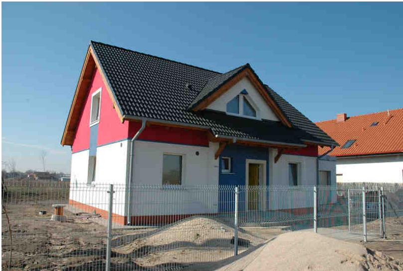
Abb.10 Ausführung des Passivhauses, Frontansicht
