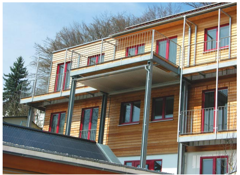
4. Dom pasywny firmy „Variotec” (2006). Zastosowane nowatorskie rozwiązania izolacyjne, wodna metoda odzysku ciepła, połączona z gruntowymi zbiornikami, zbliża ten dom do „zero energetycznego”.
