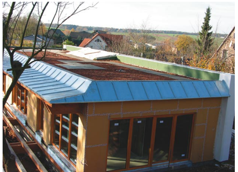
5. Dom jednorodzinny w Chemnitz (D),(2006), konsekwentnie zrealizowana koncepcja budynku pasywnego: bryła o doskonałych proporcji przegród zewnętrznych do kubatury, dobrze izolowana północna ściana, całkowicie pozbawiona okien. Pozostałe ściany o dużych przeszkleniach o odpowiednich parametrach, maksymalnie wykorzystują pasywne zyski ciepła od słońca.
