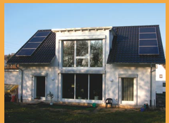
5. Dom jednorodzinny w Chemnitz (D),(2006), konsekwentnie zrealizowana koncepcja budynku pasywnego: bryła o doskonałych proporcji przegród zewnętrznych do kubatury, dobrze izolowana północna ściana, całkowicie pozbawiona okien. Pozostałe ściany o dużych przeszkleniach o odpowiednich parametrach, maksymalnie wykorzystują pasywne zyski ciepła od słońca.
